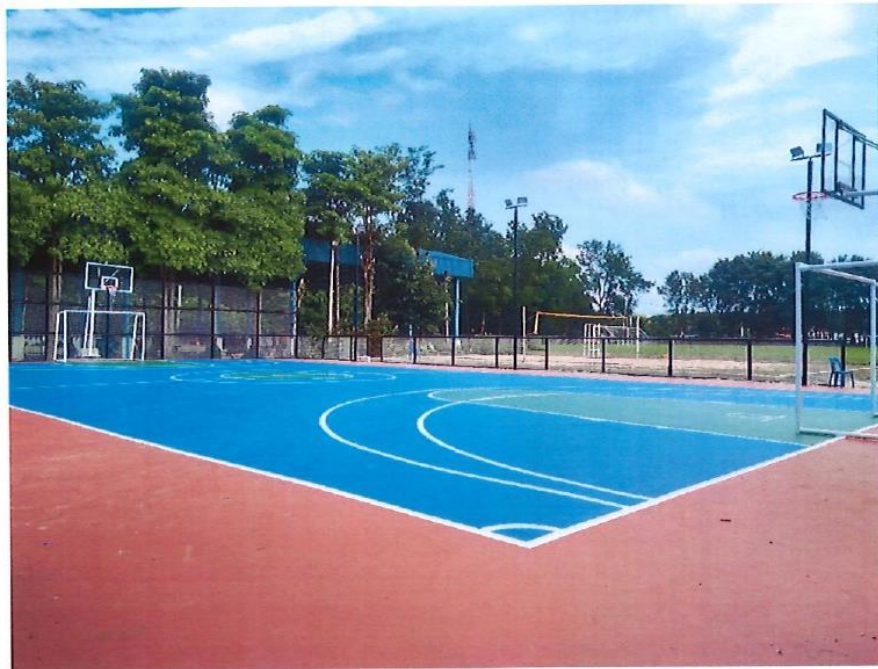
โครงการก่อสร้างสนามกีฬาากลางแจ้งพร้อมตีเส้น โรงเรียนบ้านหนองใหญ่ (คุรุราษฎร์อุปถัมภ์) อำเภอบ่อทอง งบประมาณ 1,500,000 บาท โครงการอยู่ในระดับความสำเร็จ
