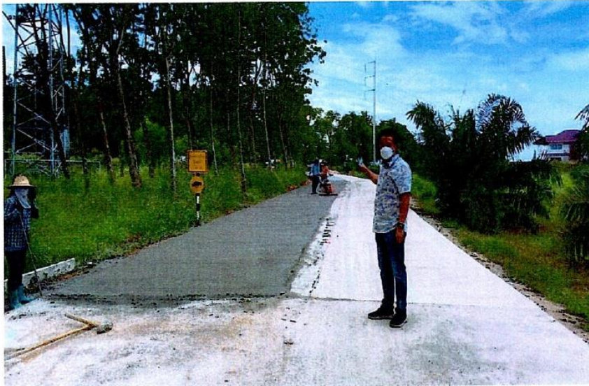
โครงการปรับปรุงถนนคอนกรีตเสริมเหล็กสาย ท.205 หมู่ที่ 2 ตำบลหนองใหญ่ อำเภอนองใหญ่ งบประมาณ 10,058,000 บาท อยู่ระหว่างดำเนินการก่อสร้าง
