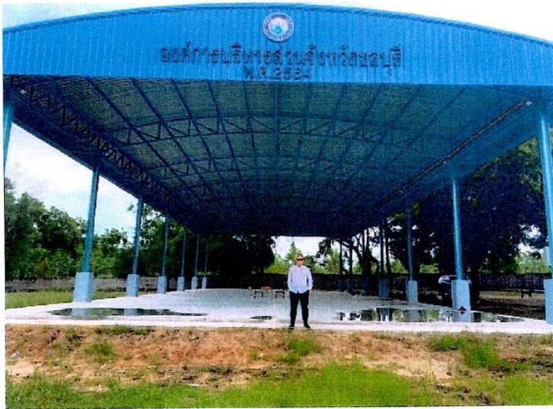
โครงการก่อสร้างอาคารอเนกประสงค์ โรงเรียนบ้านโสม (วงทวิอุปลั้มภ์) อำเภอบ้านบึง งบประมาณ 2,100,000 บาท โครงการอยู่ในระดับผลสำเร็จ
