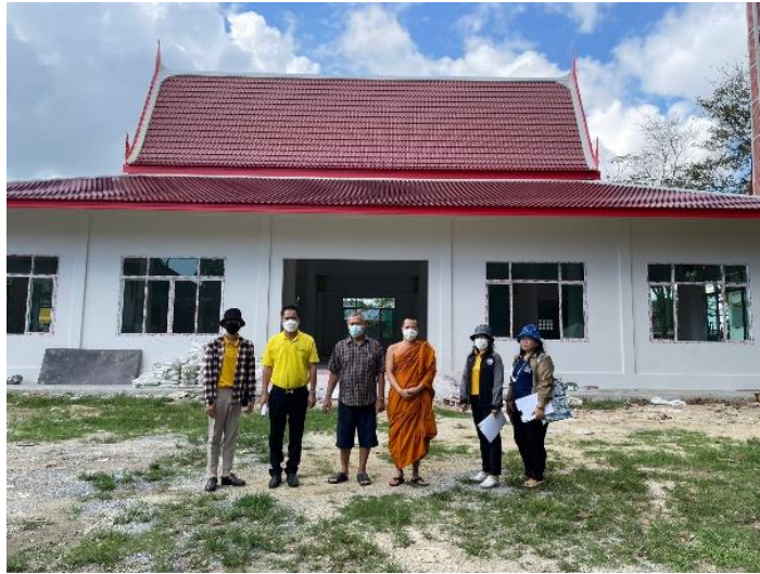
อดทนุนวัดเกาะโพธิาวาส ตำบลท่าบุญมี อำเภอกะเจันทร์ โครงการก่อสร้างศาลาอเนกประสงค์ งบประมาณ 1,000,000 บาท โครงการดำเนินการแล้วเสร็จ
