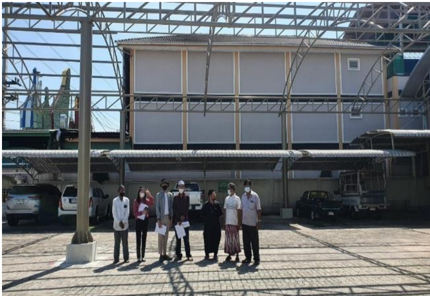
อุดหนุนมัสยิดฮิดายาตุสซาลีเก็น ตำบลนาเกลือ อำเภอบางละมุง โครงการก่อสร้างหลังคาคลุมอเนกประสงค์ฯ งบประมาณ 500,000 บาท โครงการดำเนินการแล้วเสร็จ
