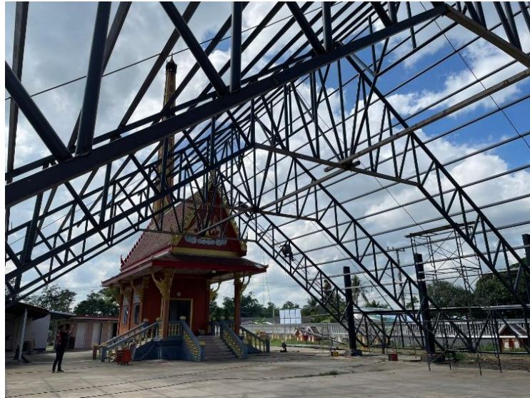
อุตุนนวัดทำบุญมี ตำบลทำบุญมี อำเภอกะเจันทร์ โครงการก่อสร้างศาลาอเนกประสงค์ งบประมาณ 1,000,000 บาท โครงการอยู่ระหว่างดำเนินการ
